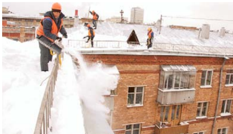
Работает «высотная бригада» РЭУ-20
